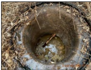
บ่อกักน้ำก่อนผ่านระบบบำบัดน้ำเสียอาคารที่พักผู้โดยสาร
