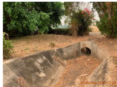
ภาพที่ 5.4-1 การตรวจสอบสภาพรางระบายน้ำภายในท่าอากาศยานน่านนคร (ครั้งที่ 1 เมื่อวันที่ 31 มีนาคม พ.ศ.2566)
